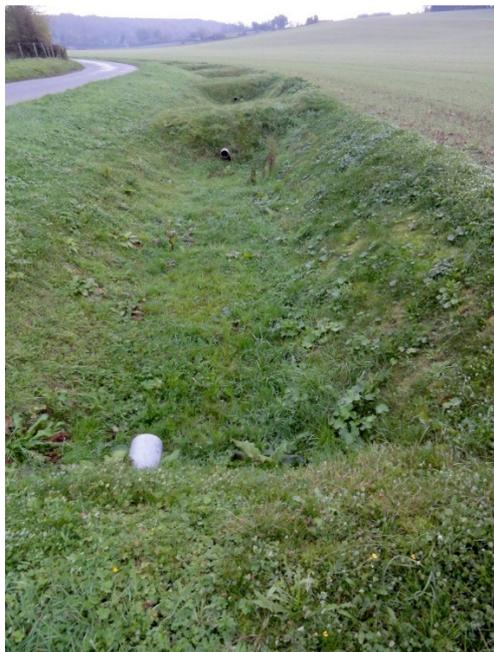
Le fossé à redents a pour objectif de collecter les eaux pluviales, mais principalement d'en stocker une grande partie grâce à des buttes aménagées en travers du fossé à intervalles réguliers. L'eau retenue par ces redents s'infiltrera au niveau de chaque compartiment ainsi cloisonné.
